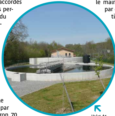
Volet A1 La station d'épuration du SAVA au Breuil
